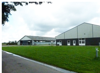
Projektet har vist, at et detaljeret beslutningsgrundlag tidligt i planlægningsfasen har stor betydning for rentabiliteten i byggeprojektet.
